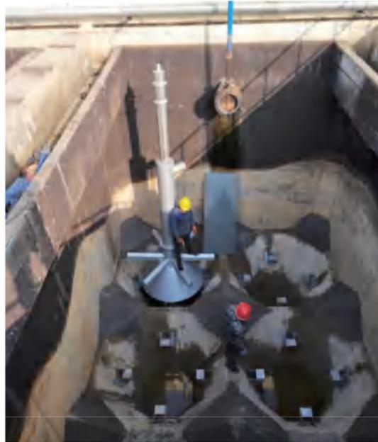
该项目为中国国电集团公司旗下污水厂项目，本项目对于改善周围水体环境，治理水污染，保护当地流域水质和生态平衡具有十分重要的作用。项目原采用“优化原生化系统+二次提升+混凝沉淀+连续流砂滤池+消毒”工艺。连续砂工艺段原采用其他厂家设备，使用期间出现了提砂状况不理想，出水水质一直不达标等情况，业主一直在寻求有效的解决办法，后经多方交流沟通，委托我司先行整改其中2个砂滤池，共12套砂滤设备，整改处理量为1万吨/天。
