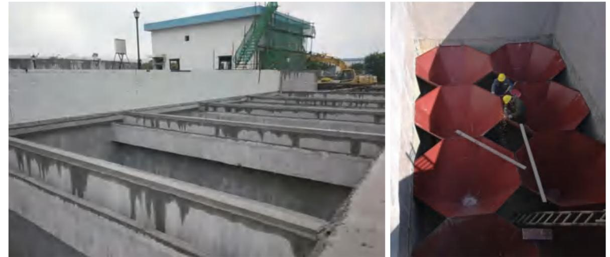
汕头市潮南区峡山污水处理厂位于广东省汕头市潮南区峡山镇，总设计规模为日处理污水7.5万吨，该项目采用“预处理+A2O微曝氧化沟+高效沉淀池+活性砂滤池+氯消毒”工艺。我司负责80套活性砂滤池设备生产制造及供货、安装调试。
