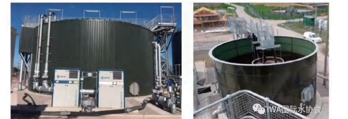
图. 位于英国Wrexham的IFAS ANITA Mox案例 | 图源: MDPI
