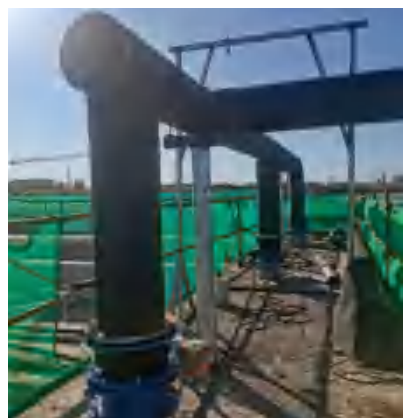
反冲洗进气管安装
