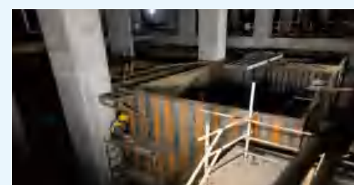
▲夜间施工赶工期
