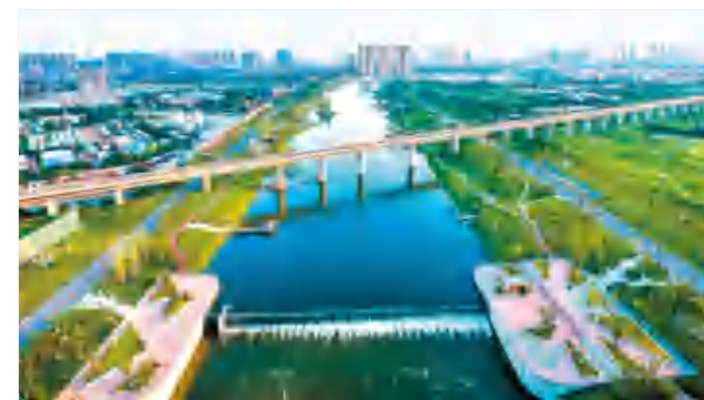
西咸新区沣西新城沣河污水处理厂
