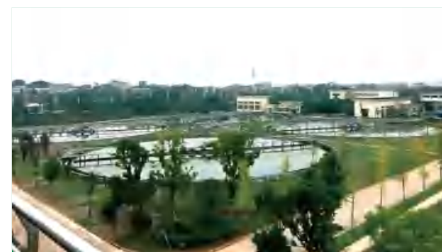
衡阳城西污水处理厂
