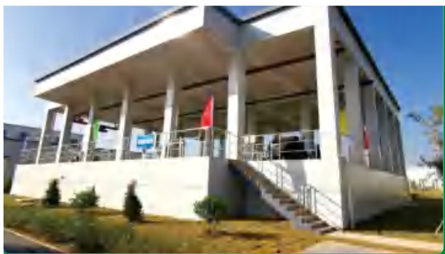
株洲市白石港水环境综合治理工程
